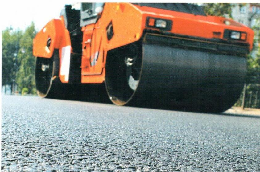
стики дорожного полотна. Кроме того, шероховатый, глубокий поверхностный слой по технологии «Сларри Сил» позволяет улучшить свойства противоскольжения.
