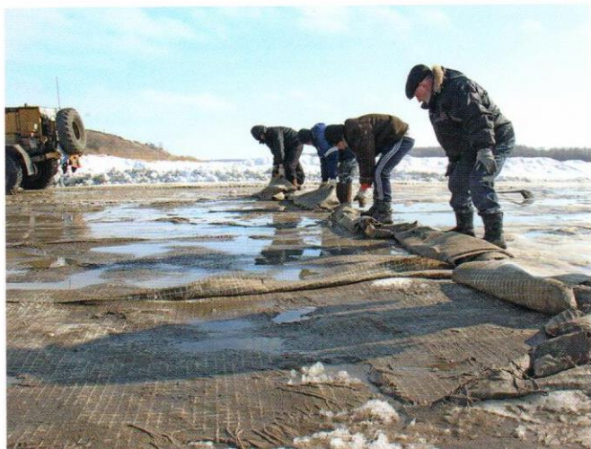
Фото 14. Удаление геосинтетических материалов
