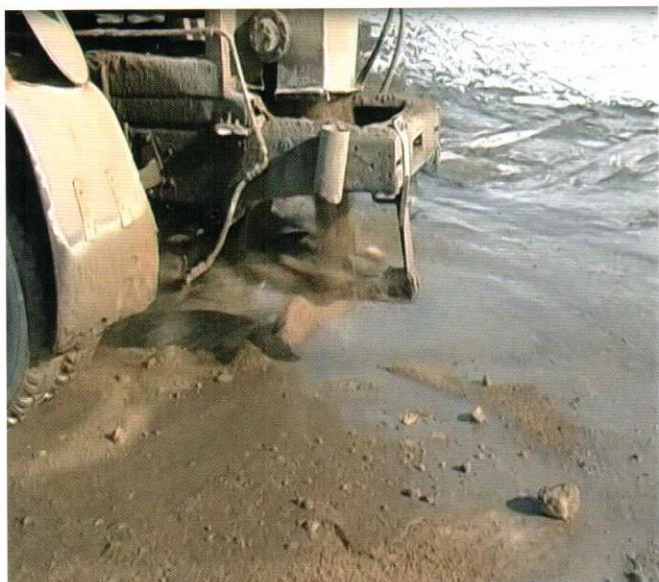
Фото 13. Распределение песка и последующее интенсивное таяние льда
