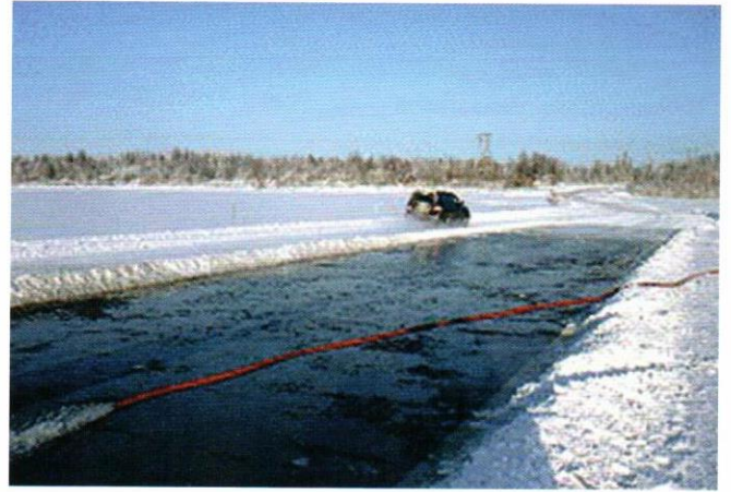
Фото 6. Распределение сетки (с перехлестом 30 см), заливка водой; толщина льда над сеткой 7 см после эксперимента и 12 см окончательная, после повторного пролива водой на второй день
