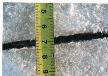
Фото 4. Трещина в неармированной ледяной плите
