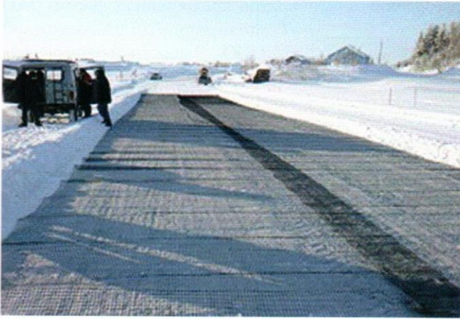
Фото 6. Распределение сетки (с перехлестом 30 см), заливка водой; толщина льда над сеткой 7 см после эксперимента и 12 см окончательная, после повторного пролива водой на второй день
