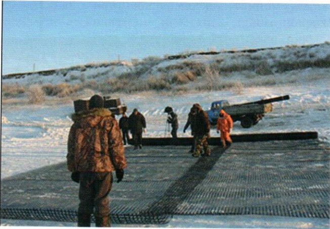
Фото 9. Укладка георешетки (на стыке ледовой плиты с берегом) и геосетки
