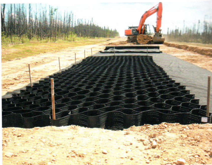
Объемная георешетка выдерживает значительные нагрузки
