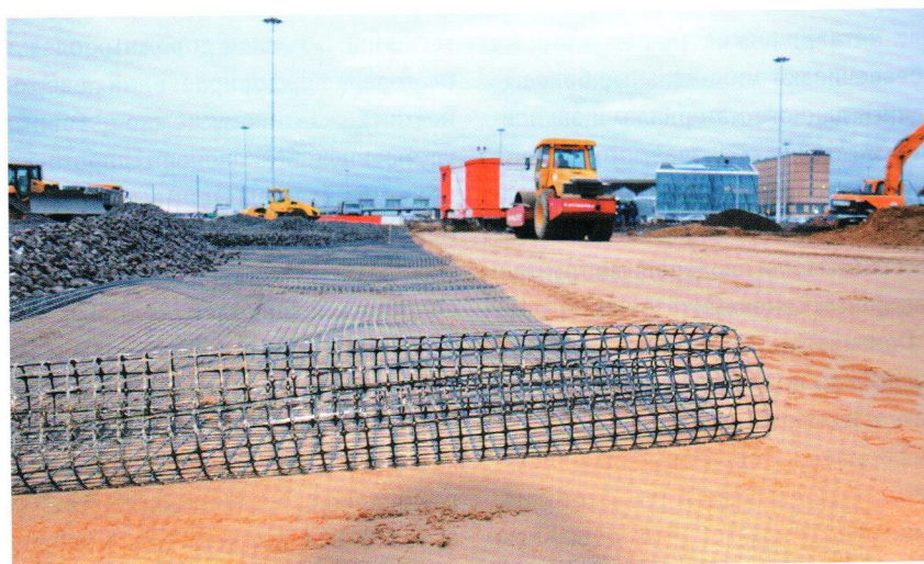
Плоская георешетка работает по принципу заклинивания и фиксации природного заполнителя
