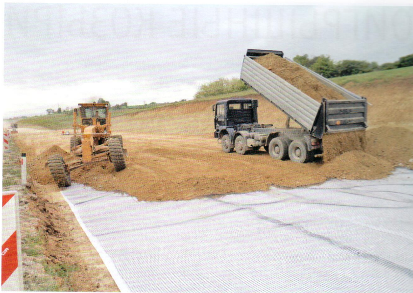
Использование геосинтетиков позволяет заменить в дорожном строительстве многие виды природных материалов
