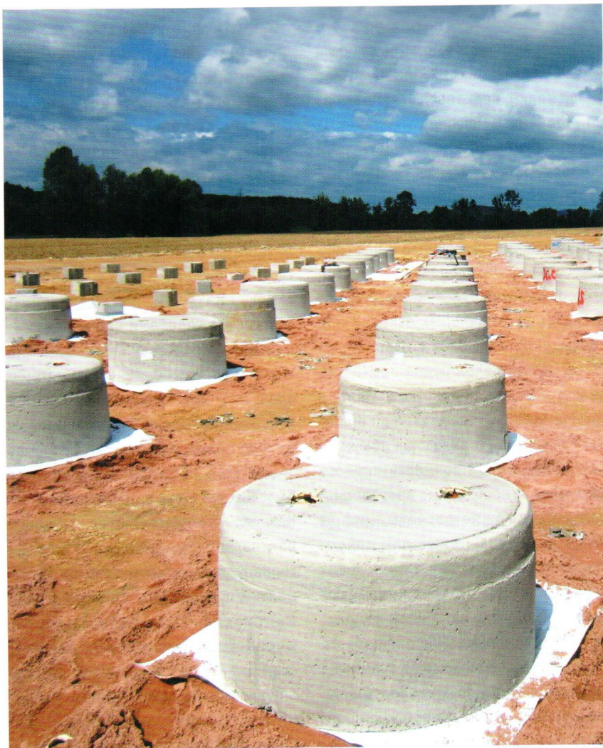
Пример круглых оголовков для свай
